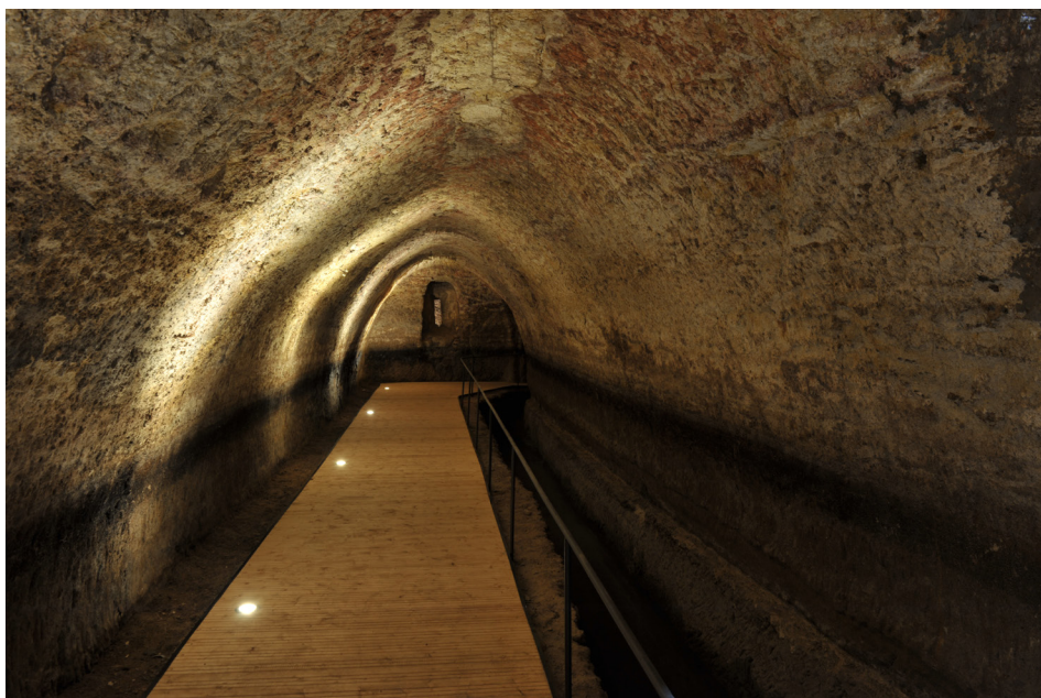
FIGURA 5. Sala principal de las galerías subterráneas. A la derecha se aprecia la zanja de posible captación de agua y al fondo la ventana saetera que comunica con la sala posterior.
