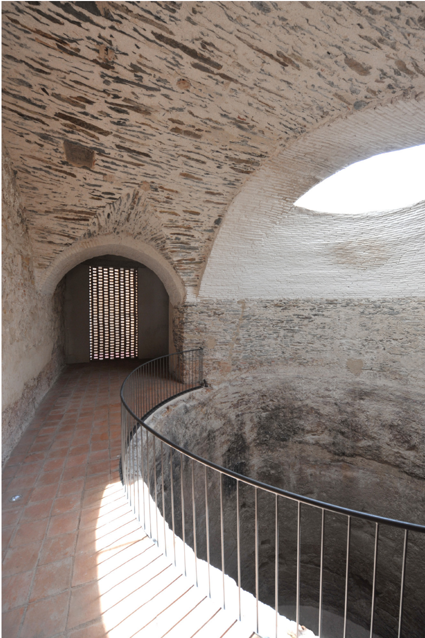
FIGURA 8a. Pozo de nieve. Estado tras la restauración. Al fondo se puede ver la celosía que indica el acceso original.
