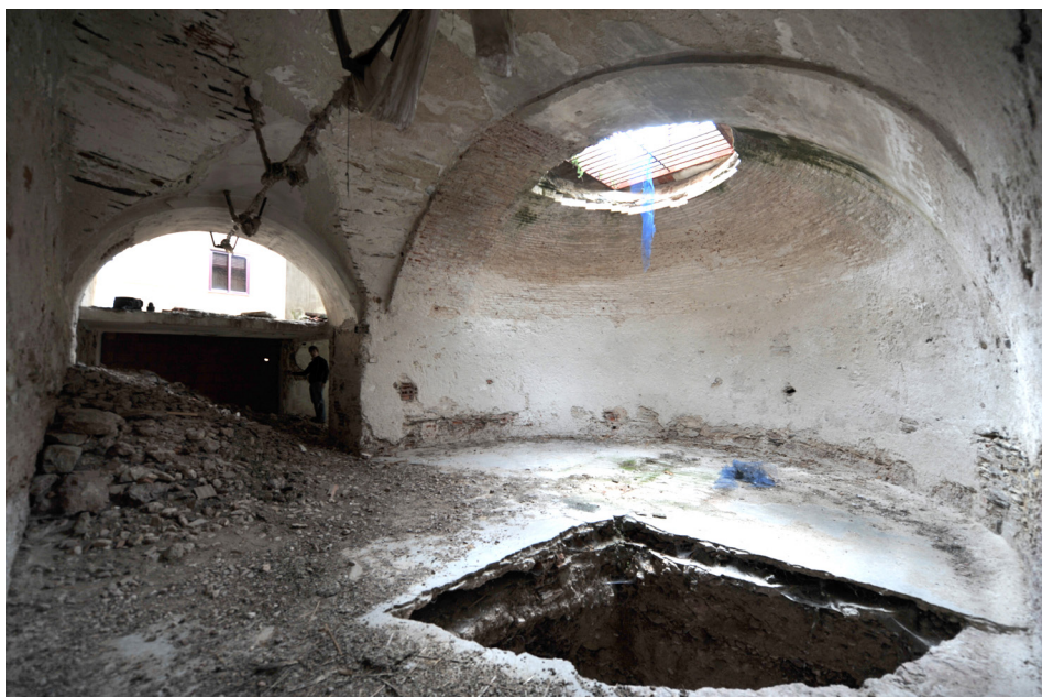
FIGURA 7. Interior del pozo de la nieve. Estado previo a la restauración. Junio 2014.
