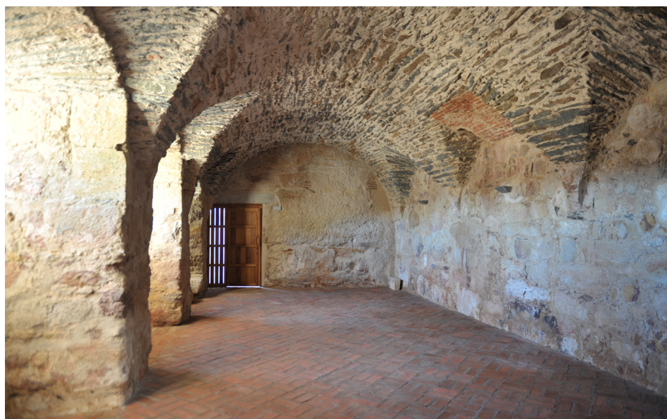
Figura 4. Caballeriza abovedada de 1717 tras la restauración.
