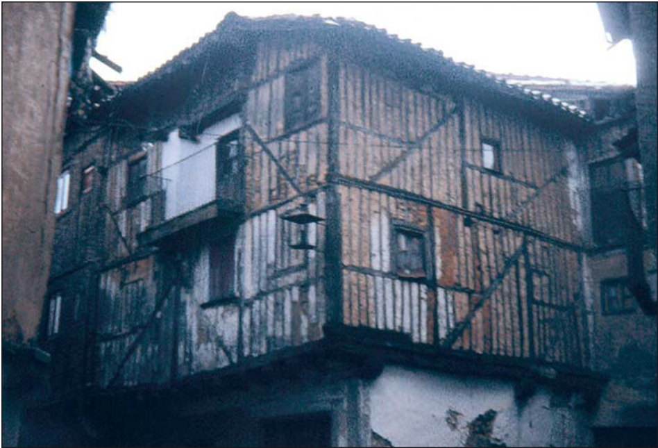
FIG. 6.—Aspecto externo de la casa albergana y huecos al exterior.
